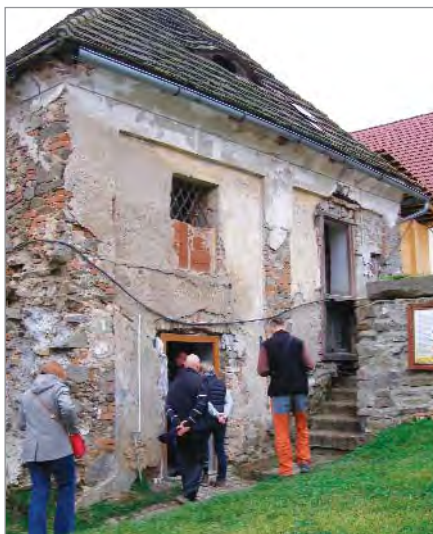
Starý špýchar prochází neustálou rekonstrukcí a slouží jako mlýnice a sklad obilovin.
