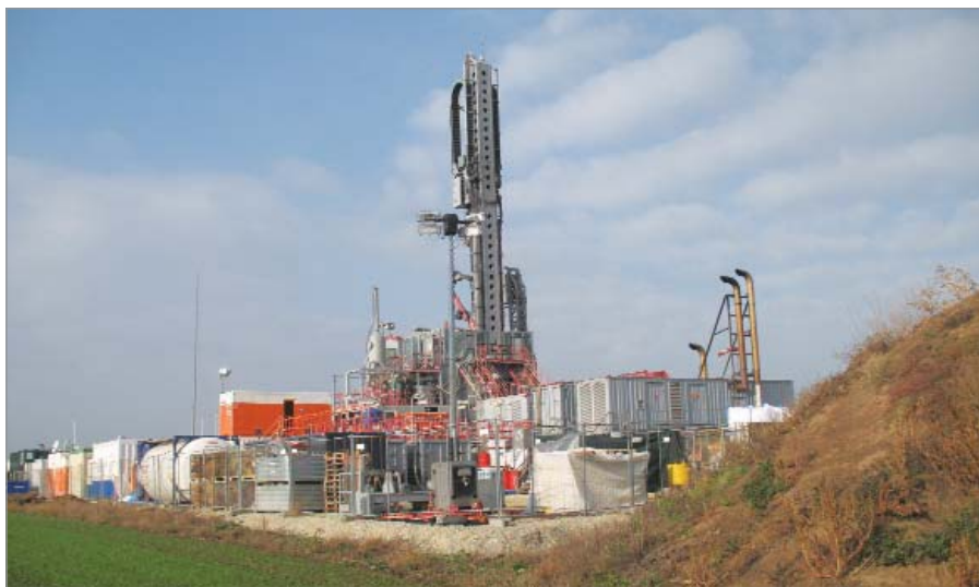
Vrt, určený ke zkoumání ložisek uhlovodíků, Rabensburg W4.
