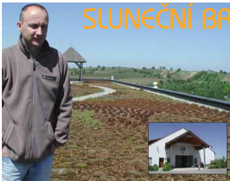
Ing. Mitaček na zelené střeše rekonstruovaného kravína
