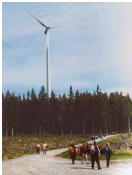
Větrná elektrárna Sternwald
